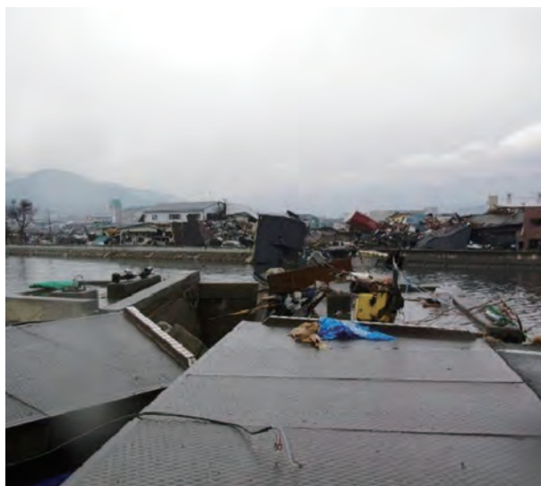
写真 2.2.23 橋桁の流失（松岩駅～南気仙沼駅間）
