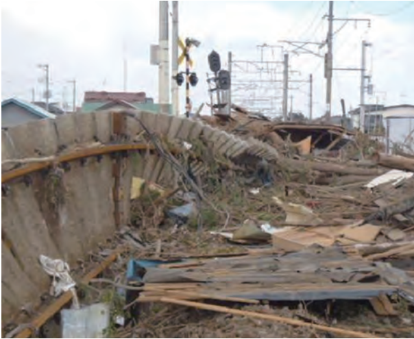
写真 2.2.9 線路の流失（山下駅）
