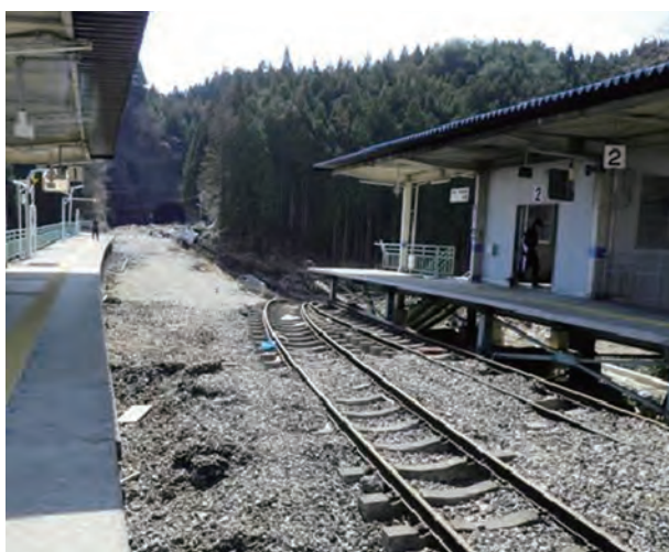
写真 2.2.21 線路の流失（歌津駅構内）
