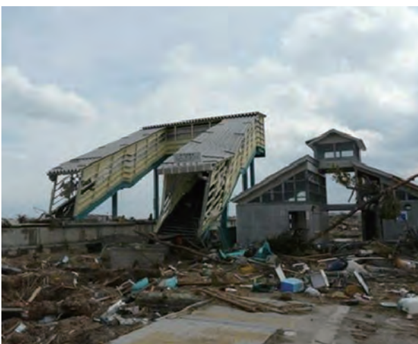
写真 2.2.10 駅舎の流失（坂元駅）
