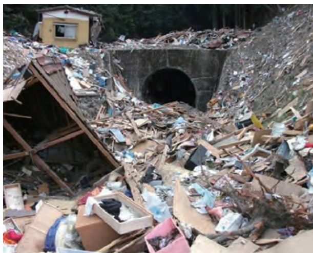
写真 2.2.20 津波襲来後の女川トンネル
