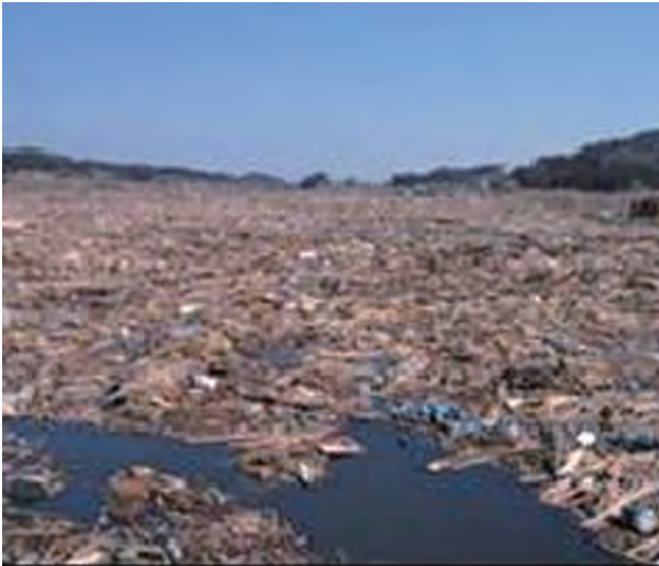
写真 2.2.43 線路流失(脇ノ沢駅～小友駅)
