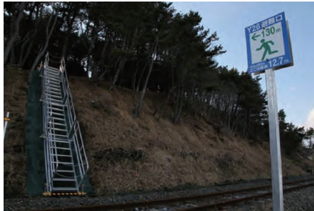
写真 2.2.30 避難通路（階段）
