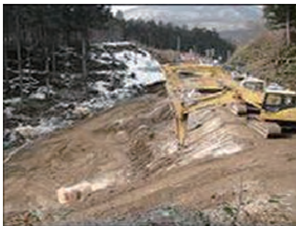
写真 2.2.50 復旧工事（仙山線）
