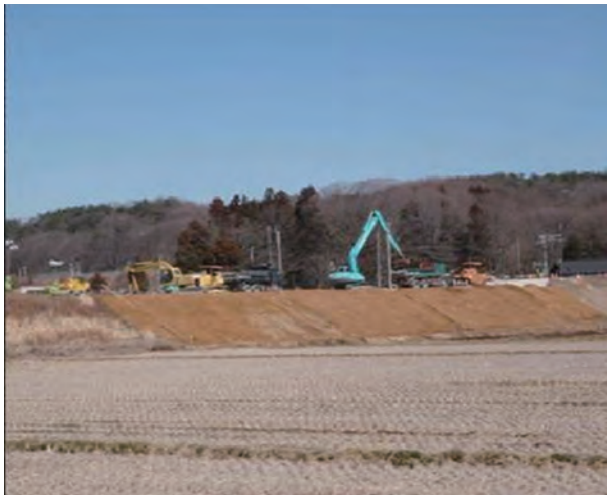
写真 2.2.8 余震の中進む復旧作業
