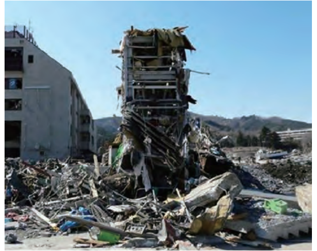
写真 2.2.18 駅舎の流失（女川駅）
