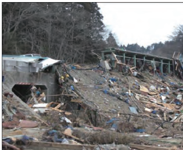
写真 2.2.24 駅舎の流出（陸前港駅）
