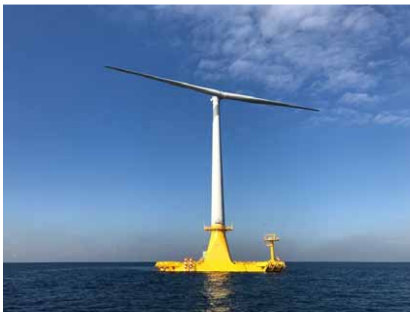
バージ型浮体式洋上風力発電システム実証機「ひびき」 提供：国立研究開発法人 新エネルギー・産業技術総合開発機構
