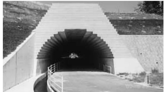
RCCカルバート
