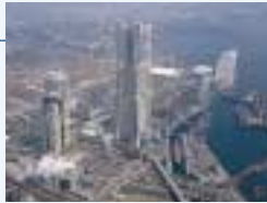
着々と進む施設建設 1994(平成6)年
