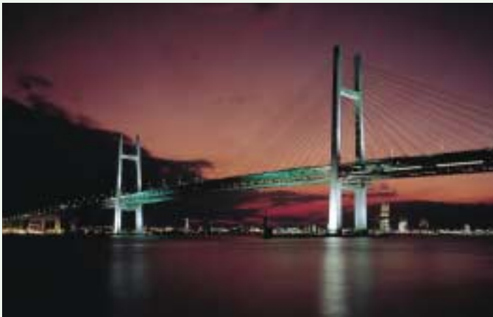
横浜ベイブリッジ 橋長860m 上下6車線
