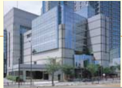
みなとみらい121クリーンセンター
