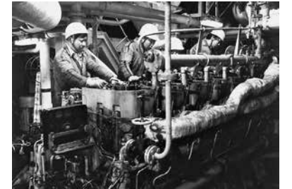
外航貨物船の機関室でエンジン整備
