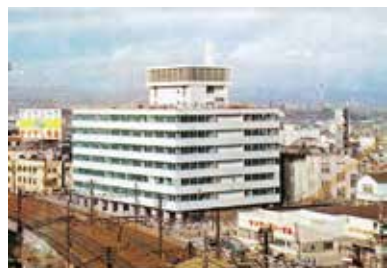
完成した本社ビル全景(1961.12)
