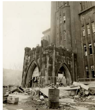
東大紛争直後の安田講堂正面。バリケードの跡 が残り、窓やサッシは破壊されている。文書館所蔵 [紛争による建物被害写真](施) S0041/0029
