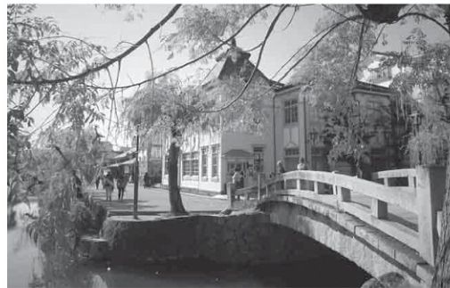
倉敷館（岡山県倉敷市）倉敷市指定有形文化財。旧町役場。旧庁舎と同じで、耐震性の問題から2階が使えない状態であった。建物全体を有効に活用するため、平成26年度から修理計画が立てられ、平成29年度から着工、令和元年完成予定。
