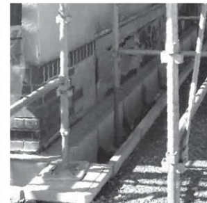
【外部の基礎部分】外周の基礎工事が終わり、既存の基礎を内と外の両側から補強できました。床下への雨水侵入の原因や床下換気を妨げていた屋外スロープは撤去し、側溝を設けました。
