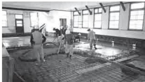
上／打設直前のコンクリート品質検査 下／基礎コンクリート打設中の様子
