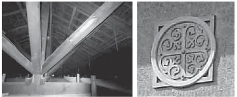
小屋裏に組まれたキングポストトラス 外壁のメダイオン(装飾)
