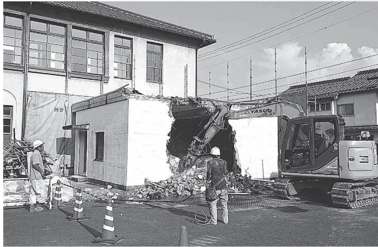
8月2日 旧加悦町有線テレビスタジオ解体の様子
