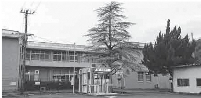
移設する電柱（写真左）、伐採するヒマラヤヤシ（写真中央）、ヒマラヤヤシ右隣のカイズカイブキも、一部を剪定します。現在ヒマラヤヤシがある場所に電柱を移設します。
