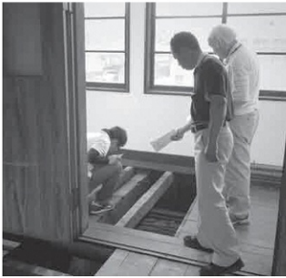
昨年6月の構造詳細調査。2階の梁と1階のフツエとの接合方法を確認しました
