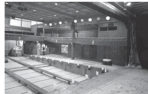
左・右ノ加子母明治座（岐阜県中津川市）明治27年に建築された地歌舞伎と芝居小屋。平成27年度に耐震改修工事を実施。屋根の重量を軽減するため、瓦葺きとせず、柿葺き石置き屋根として創建当時に復元。冬季は積雪量を考慮して入館を制限。ハード面で補えない部分をソフト面に対応。
