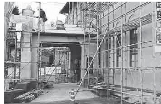
屋根部分を修理中の車寄せ
