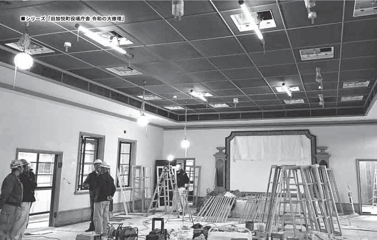
12月19日、修理工事中の旧議場（建物2階）の様子
