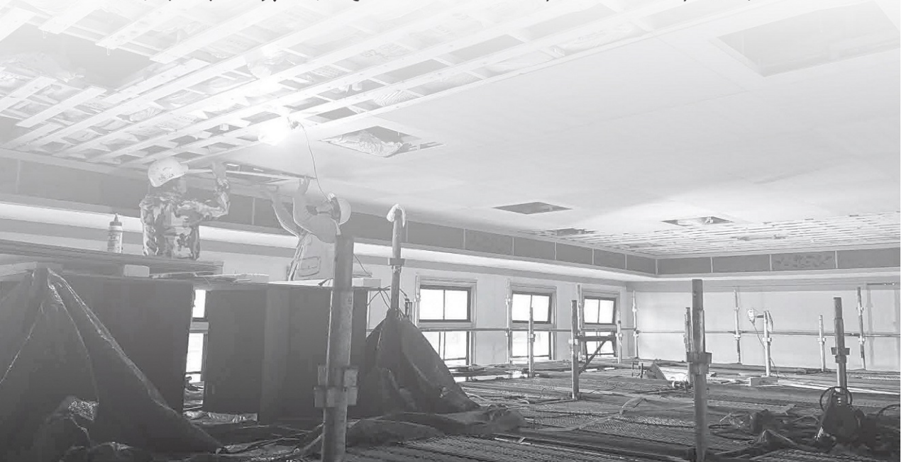
12月5日 修理中の2階旧議場の天井
