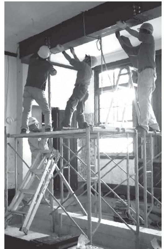
左・右 鉄骨の新設には、11月6日・7日の丸2日間を要しました。修理工事のため重機が入らず、人力で大変な作業となりました。
