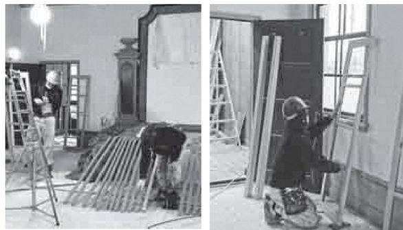
屋外に接する建具の復原工事の様子。なお、文化財保存修理のため、既存の窓ガラスは、慎重に取り外して再利用します。破損などやむを得ない部分のみ新しいガラスに替えます。
