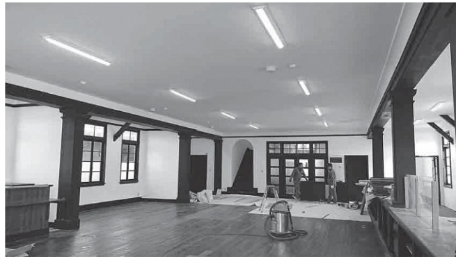
2月6日に撮影した1階の様子。写真左側（建物西側）の耐震補強のための鉄骨梁、それを支える柱、補強壁の仕上げが完了しました。写真右側（建物東側）の建築時の鉄骨梁と柱の仕上げに調和するよう漆喰と木材で仕上げています
