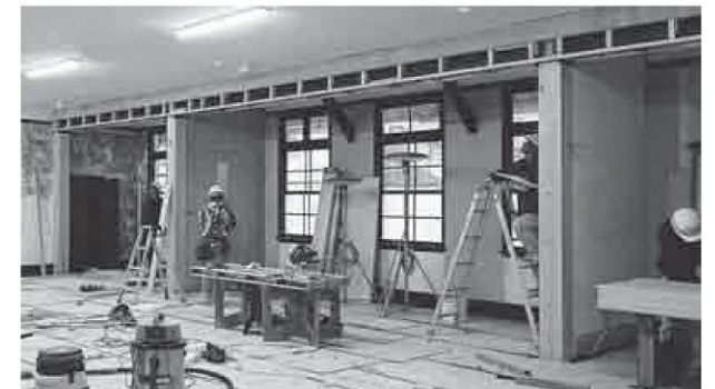
建物西側に新設された、耐震補強のための梁・柱・壁
