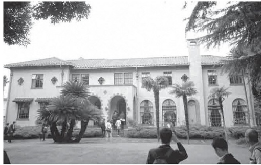
ペーリック・ホール（横浜市山手地区） 昭和5年設計
