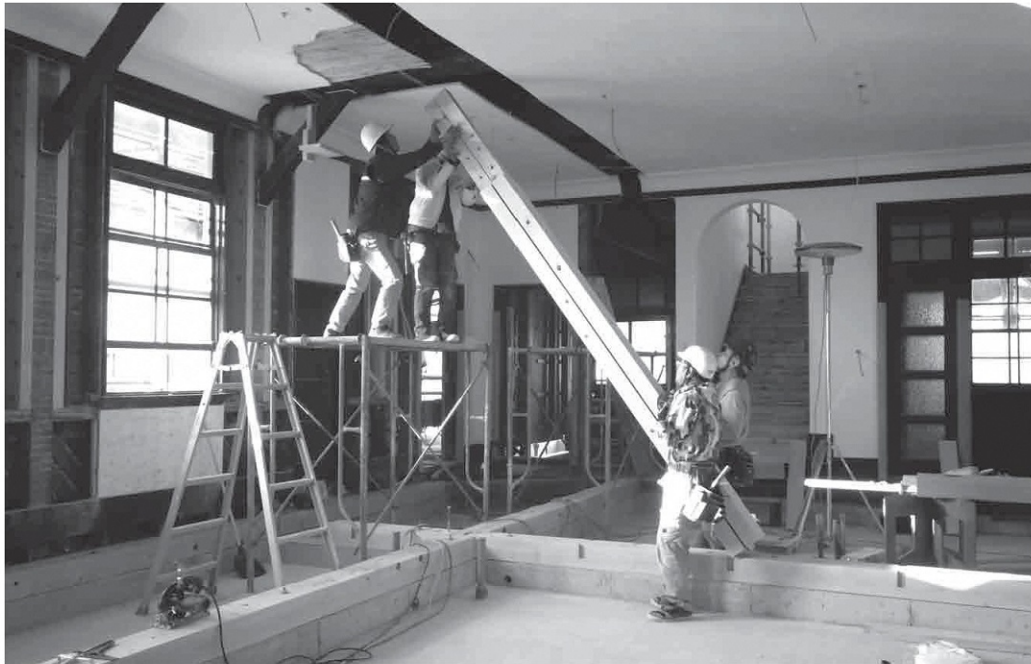
11月5日、耐震補強のため新設の柱4本を据えました。この柱が新設する鉄骨梁を支えます。
