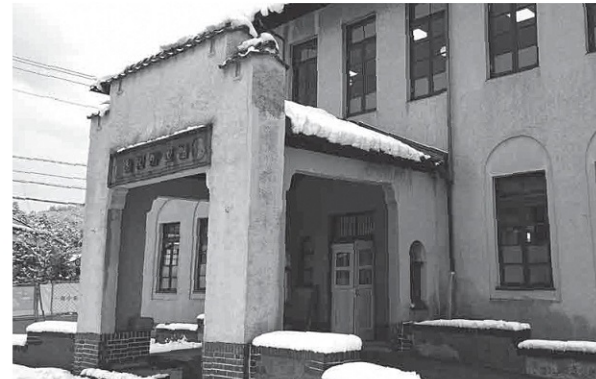
2月6日、玄関北東から撮影。車寄せの修理も大部分が完了しました。文化財の修理工事のため、修理後の外観に変化はほぼありません。ただ、建築時から続く現状の外壁は、スタッコ塗りと呼ばれるもので、施工には技術と手間を要し、建築物に重厚感や高級感を生む仕上げです。旧加悦町役場庁舎のものは特に手が込んでいる海綿タキ仕上げで、同じように施工することが難しく、魅力のひとつと言えます
