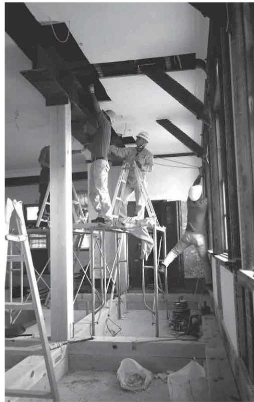
左・右 鉄骨の新設には、11月6日・7日の丸2日間を要しました。修理工事のため重機が入らず、人力で大変な作業となりました。
