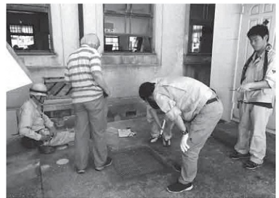
左/右/昨年7月の外壁と基礎コンクリートの調査。シュミットハンマーで強度を調べました。※シュミットハンマーとは、コンクリートの圧縮強度を測定するもの。建物に損傷を与えずに検査ができる非破壊検査手法（文化財に配慮）
