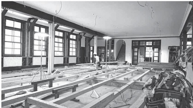
11月14日の建物内部（1階）。外周の柱は内側から添柱で補強しました。
