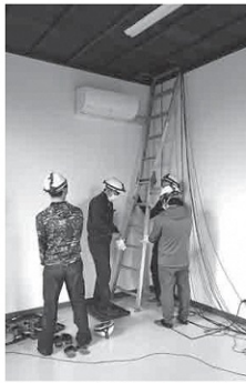
小屋裏に起振機を設置する様子
