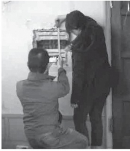
昨年4月の内壁調査。どのような仕様となっているか一部を取り外して調査
