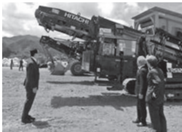
▲大型機械が配備され処理の効率化がはかられます
