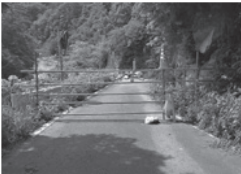
道路の復旧が待たれます（県道大川松草線）
