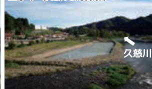
施工(株)大藤組
