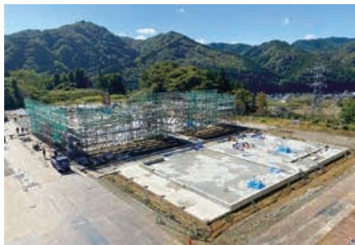
新庁舎建設工事全景
