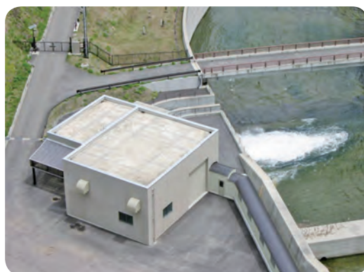
発電所の建屋
