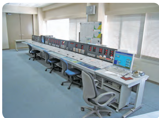
ダムの管理施設
