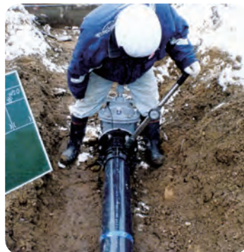
水道管を交かんしているところ
