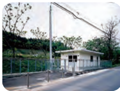
塔寺 とうてら ポンプ場
