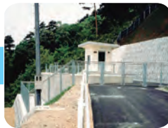
高寺 たかてら 配水場
