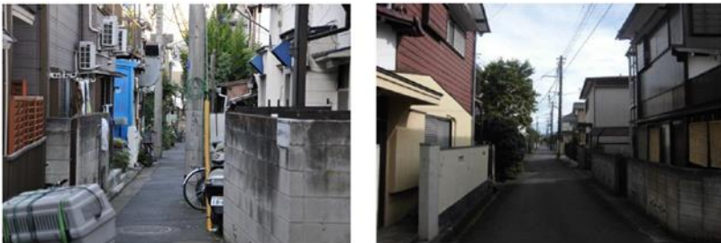
図：木造住宅密集地域内の状況
