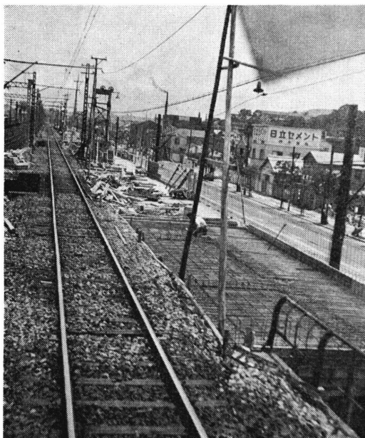
高島町～桜木町間複線化工事
