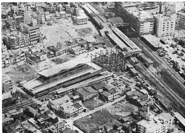
改良工事の進む蒲田駅
