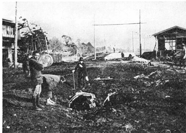
丸子（現沼部）付近における目蒲線建設工事
