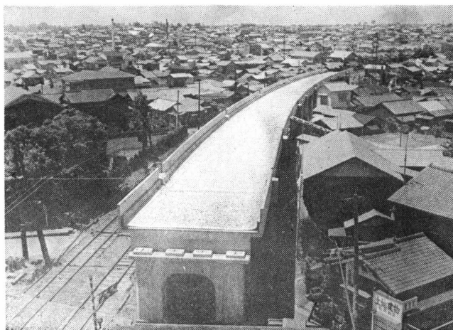
高架化工事の中延駅付近
