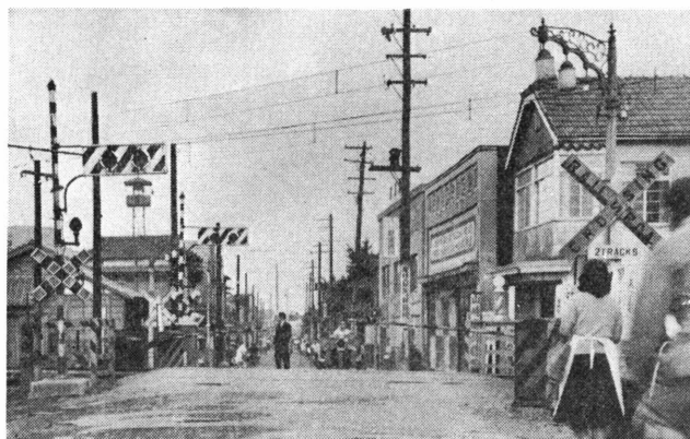
自動遮断機が設置された戸越公園2号踏切道
