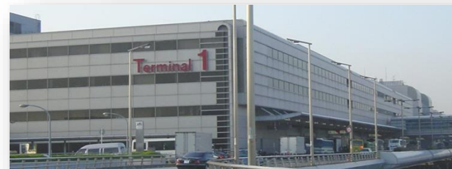
羽田空港第1旅客ターミナルビル
