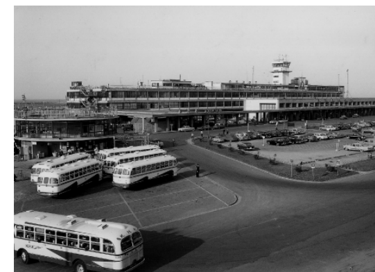
開館当時の羽田空港旅客ターミナルビル
