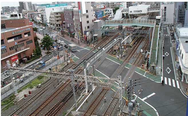
2013年9月(工事着手直後の37号踏切道)
