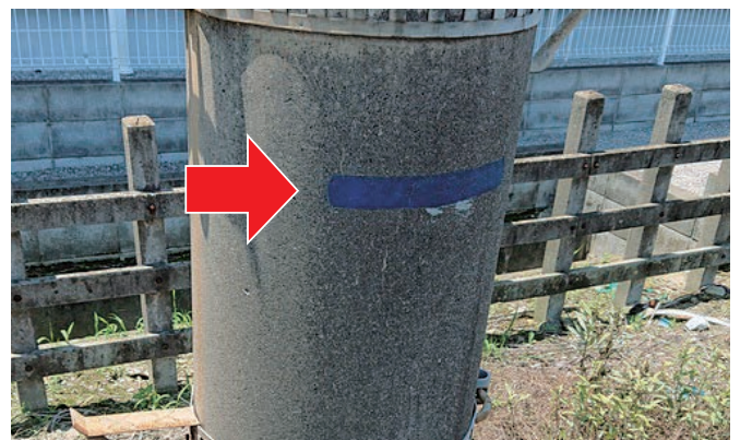
浸水深マーキング
