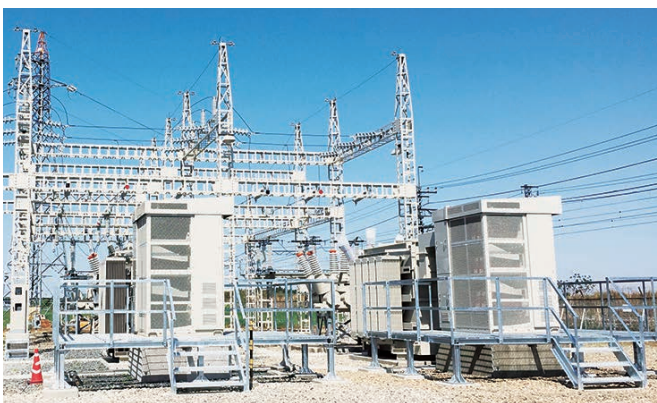
基礎かさ上げ後
