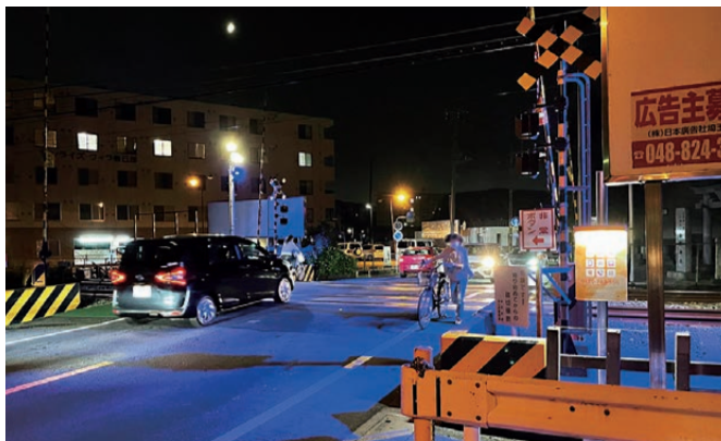
踏切青色照明
