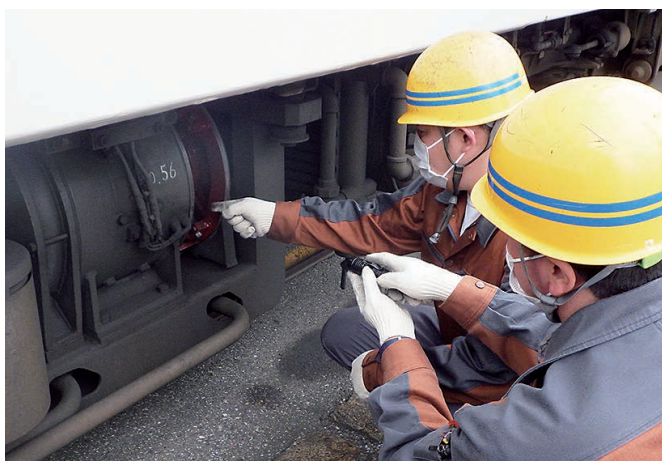
床下機器点検
