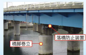
▲耐震補強の事例
