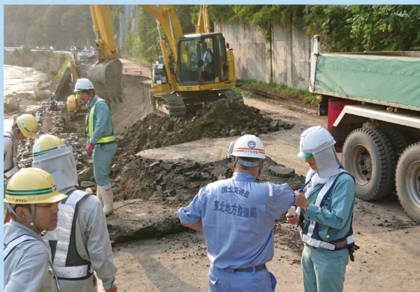
▲国道106号の応急復旧
