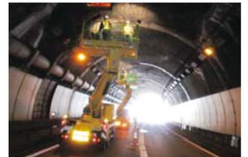
トンネルの点検
