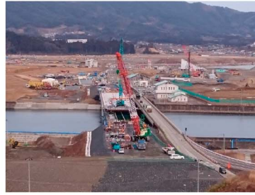
▲床版工の工事状況
