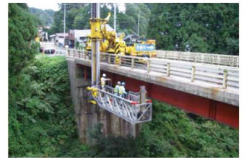
橋梁点検車による点検
