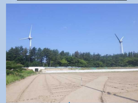
(3) 藤崎地区 No.324(並走区間)
