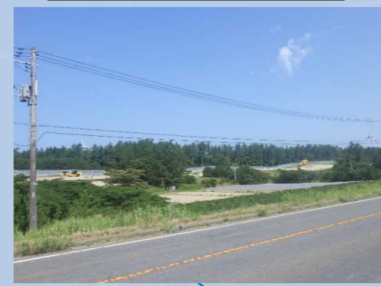
(2) 藤崎地区 No.275(並走区間)
