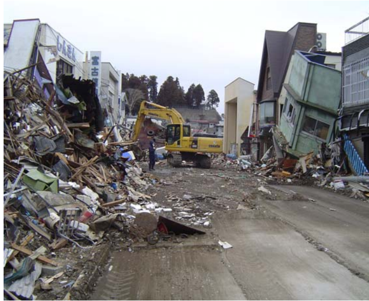
▲啓開作業中(岩手県山田町内を撮影)
