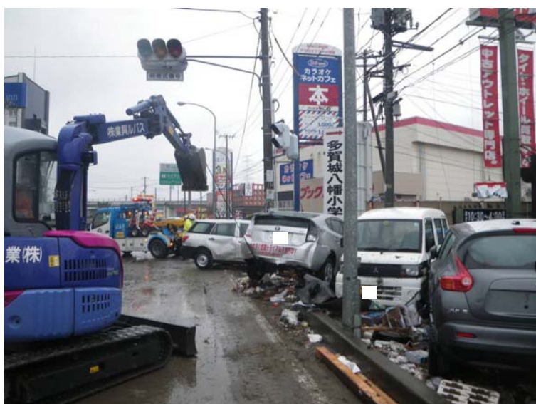
▲啓開作業中(多賀城市市街地を撮影)
