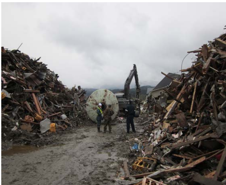
▲啓開作業中(岩手県陸前高田市内を撮影)
