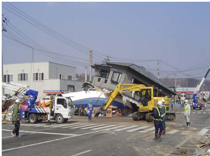
▲啓開作業中(宮古市市街地を撮影)
