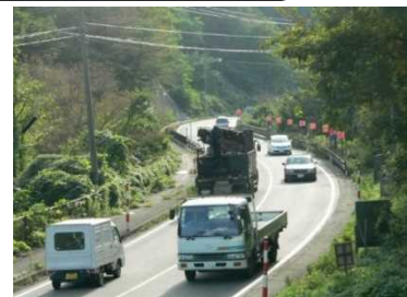
▲国道7号の線形不良箇所
