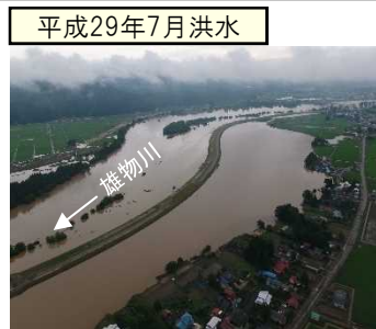
[雄物川本川の浸水状況]
