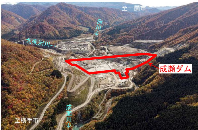
[下流側から望むダムサイト施工状況]
