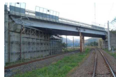
▲白沢跨線橋全景
