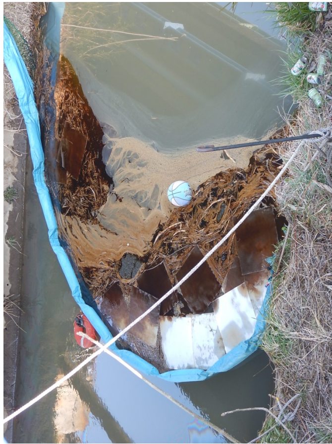
オイルフェンス設置状況
