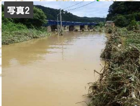
▲(主)戸沢大蔵線の被災状況 (冠水)
