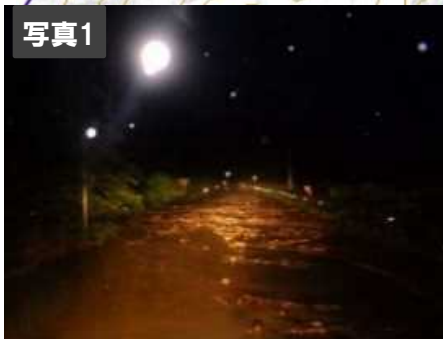
▲国道47号の被災状況 (土砂流出)
