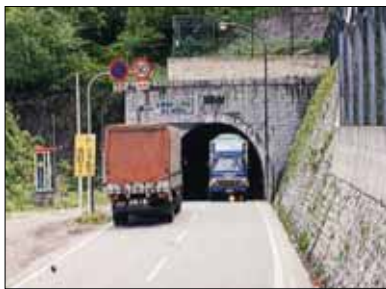
現在の国道13号
