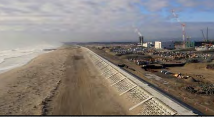
施工状況／仙台湾海岸（井土浦）
