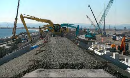
施工状況／山元海岸（坂元川）
