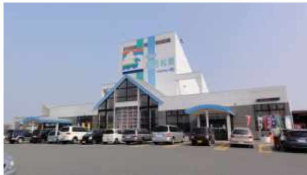
写真4 震災以前の道の駅「高田松原」
