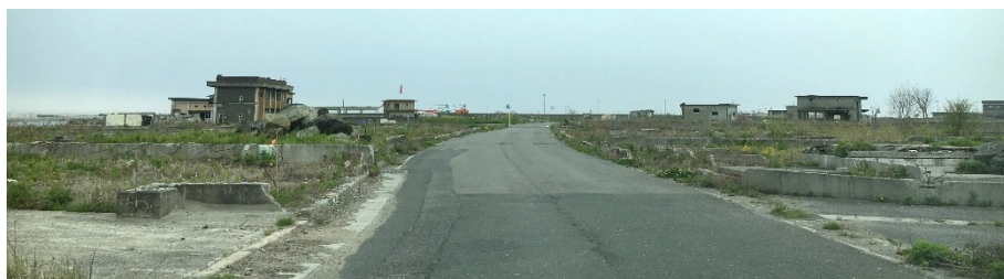
写真 -4-1 津波により被害を受けた請戸漁港周辺市街地（浪江町）
