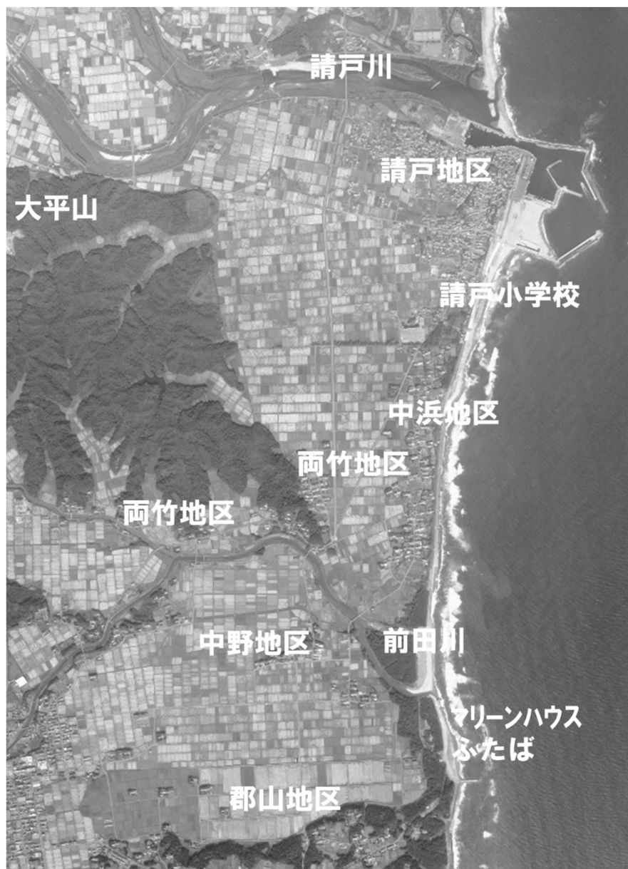
写真 -4-10 双葉町・浪江町沿岸部の様子（2000）
