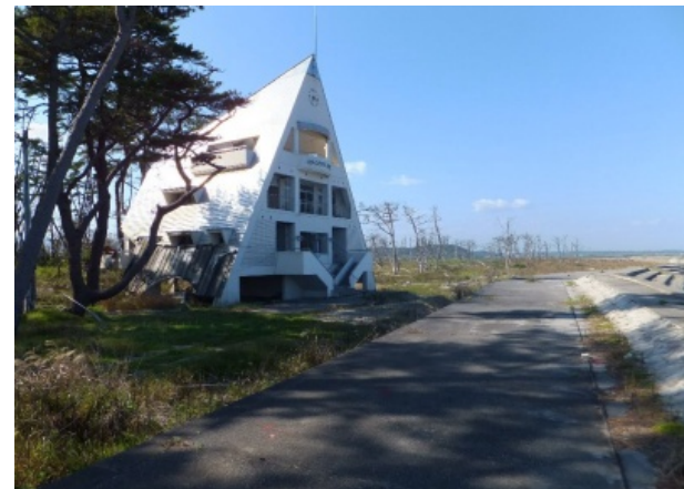
マリンハウスふたば (双葉町) 東日本大震災による津波で3階建の2階まで浸水。最上階に避難した住民は無事であった。
