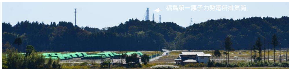
写真 -3-2 丘陵部樹林越しに望む、福島第一原子力発電所の排気筒
