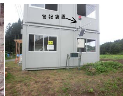
写真13 警報装置の設置
