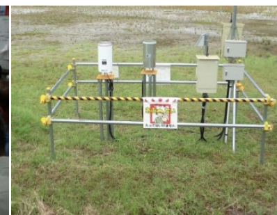
写真10 現地雨量計の設置
