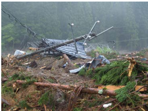
写真4 なぎ倒された電柱
