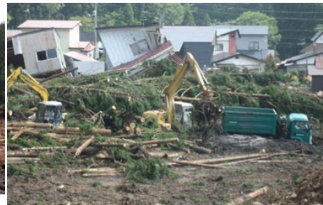
写真3 家屋被災状況
