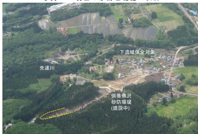
写真 18 施工中堰堤と保全対象
