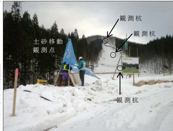
写真 16 冬期間の崩壊斜面測定状況
