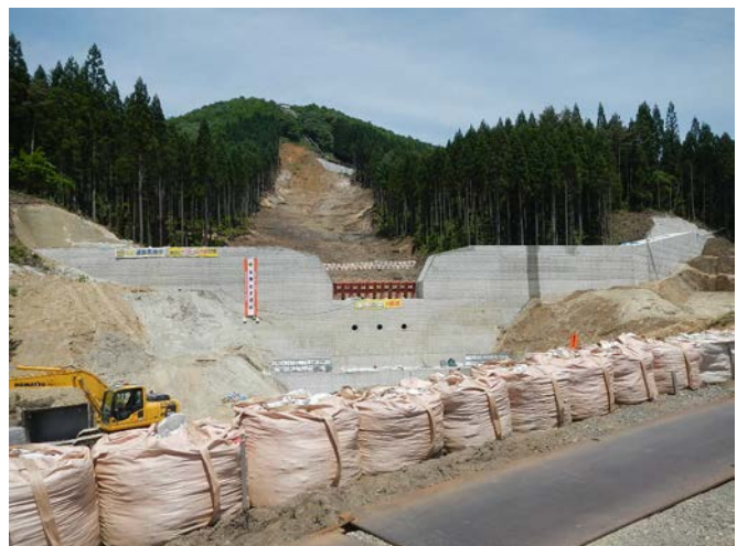
写真 17 現在の砂防堰堤施工状況
