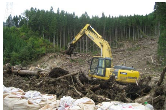
写真15 散乱した流木撤去から工事着手
