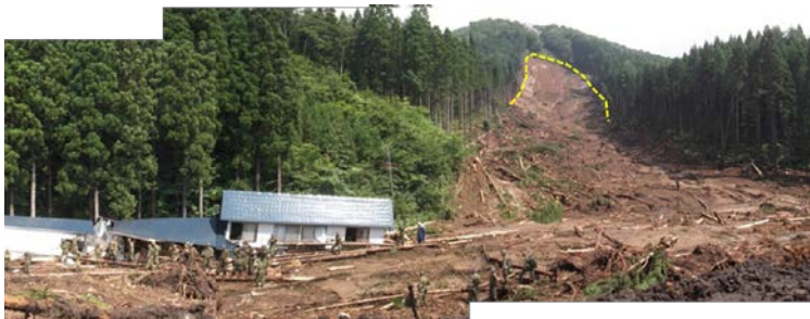
写真2 土石流発生状況（地上撮影）
