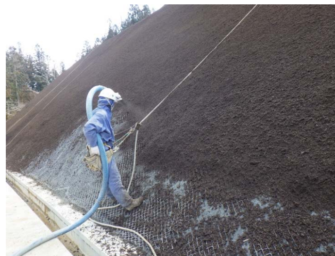
▲ 植生基材吹付の施工状況
