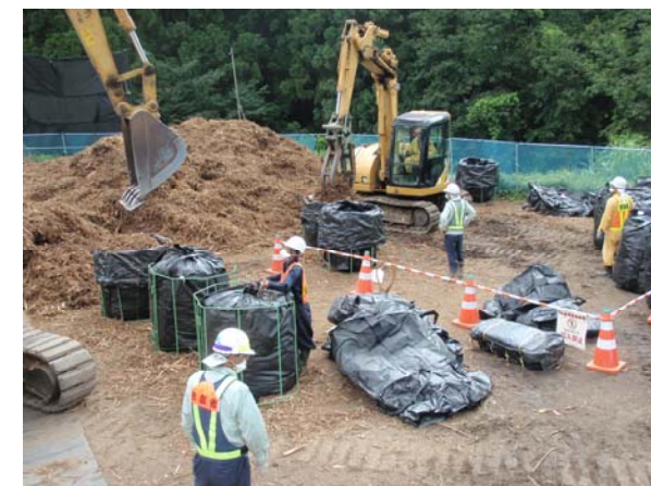
▲土のう詰め込み状況
