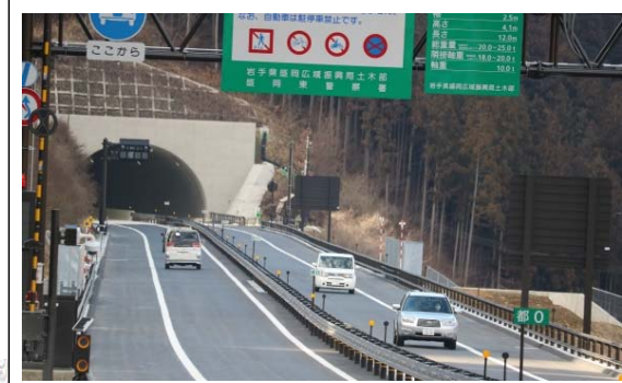
①新川目トンネル宮古側坑口
