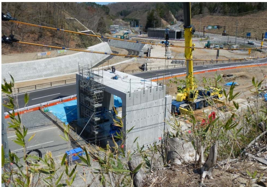
▲ 田野畑北IC (仮) ~ 下閉伊郡普代村第11地割 普代村第11地割地内の本線横断BOX設置状況
