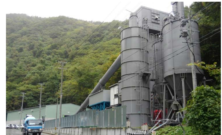
▲川井地区仮設プラント
