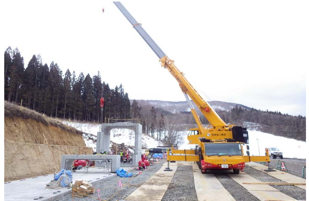
▲遠野住田IC～遠野IC 鍋倉地区の本線横断BOX設置状況
