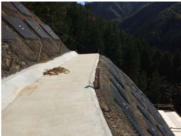
▲シールコンクリート打設状況
