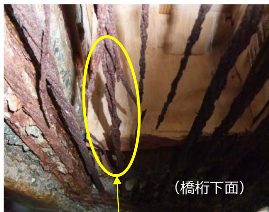
PC鋼材破断イメージ
