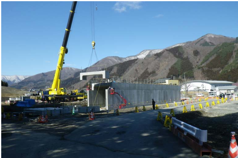
▲釜石JCT～釜石西IC 松倉南地区の本線横断BOX設置状況
