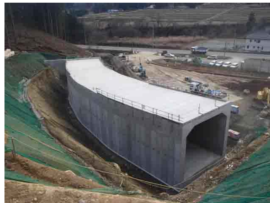
▲相馬IC～相馬山上IC 間ノ次郎地区の本線横断BOX設置状況
