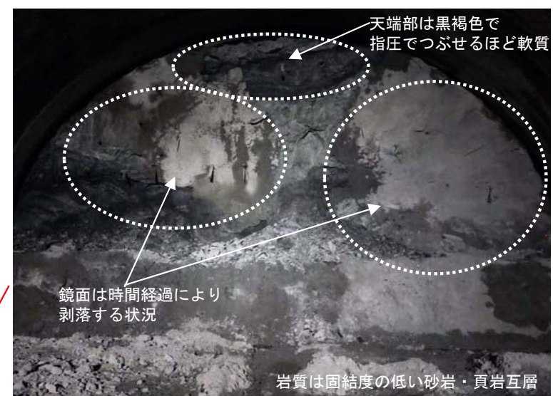
【今回支保構造変更区間の切羽状況】
