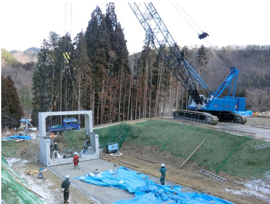
▲宮古～箱石 腹帯地区の本線横断BOX設置状況
