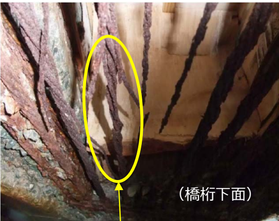
PC鋼材破断イメージ
