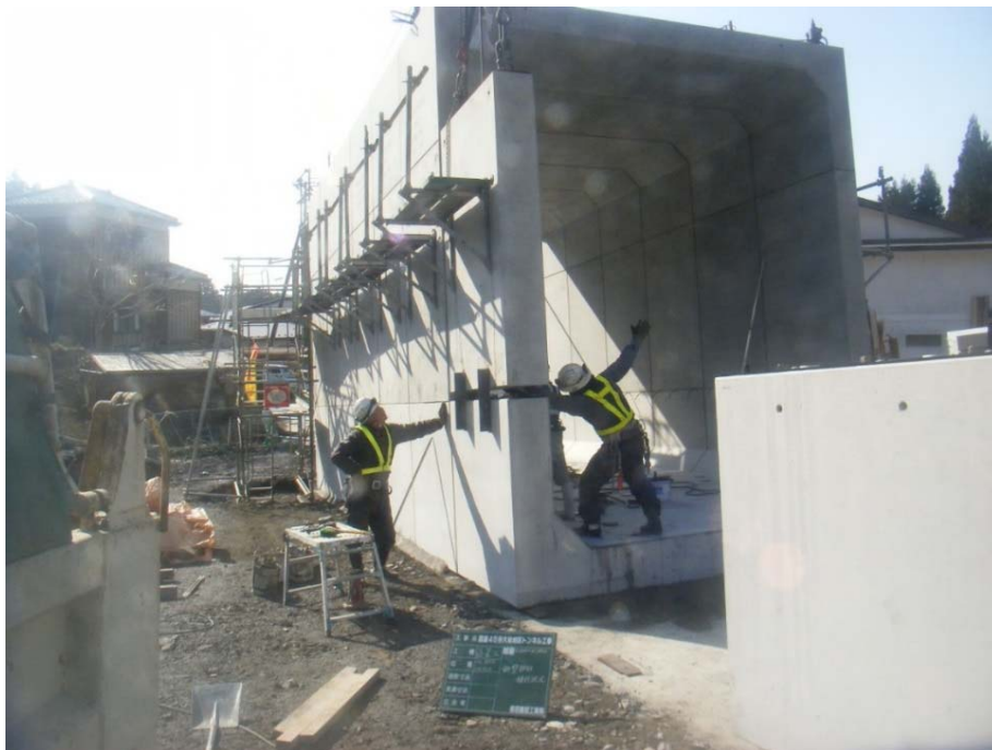
▲大槌IC～山田南IC 大槌地区の本線横断BOX設置状況①
