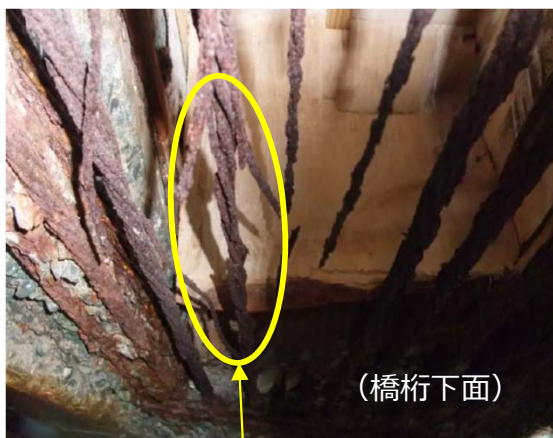
PC鋼材破断イメージ
