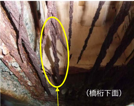
PC鋼材破断イメージ
