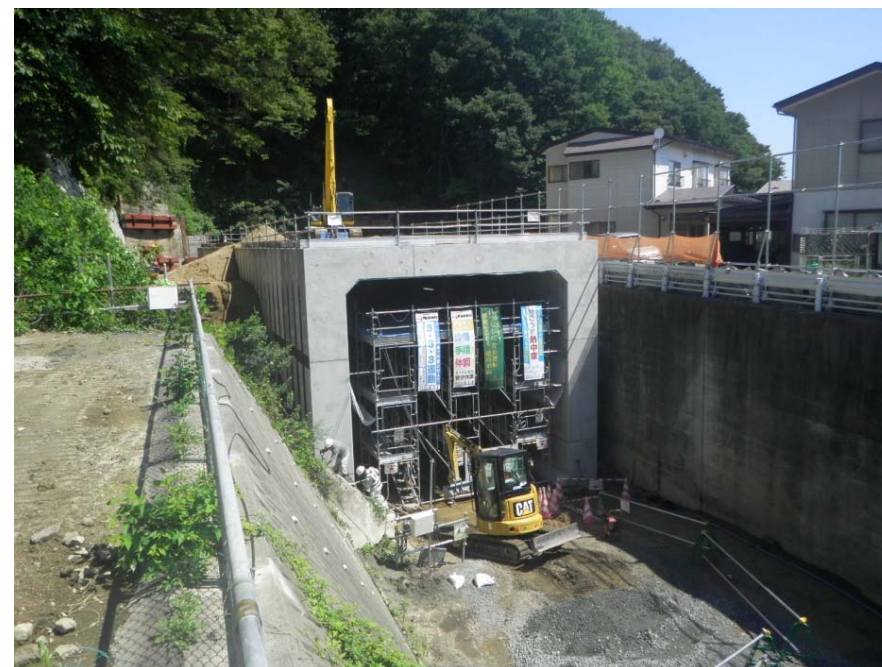
▲宮古～箱石 藤原地区の本線横断BOX設置状況
