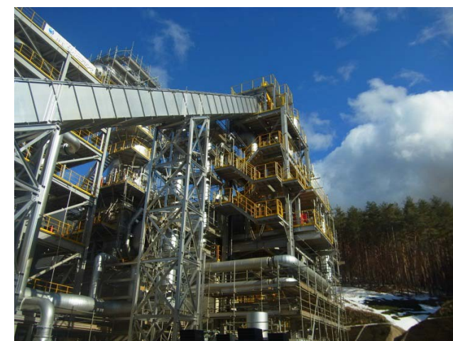
▲仮設焼却場 (伊達衛生組合)
