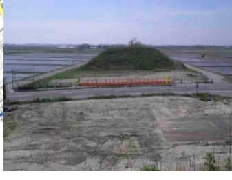
⑤払田二道橋下部工
