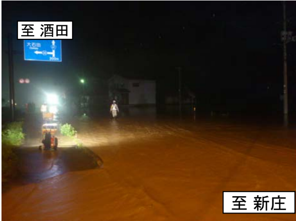
▲国道47号 新庄市畑地区の冠水 (H25年7月18日)
