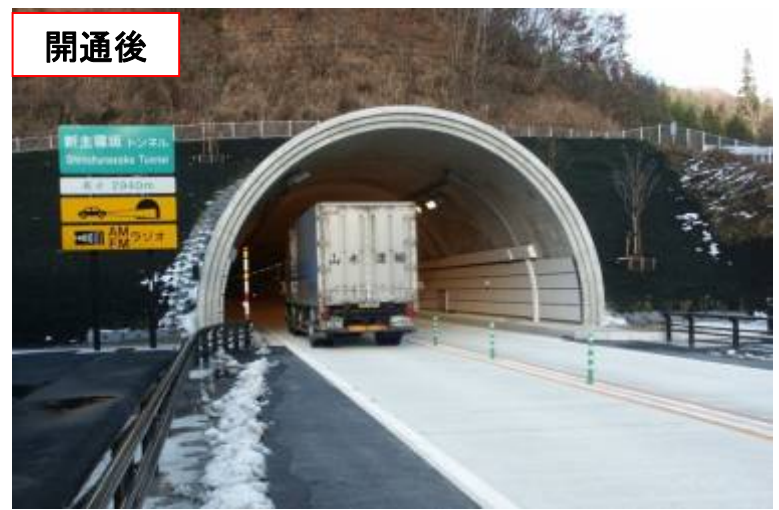
▲開通後の主寝坂道路(新主寝坂トンネル) (H17.12)
