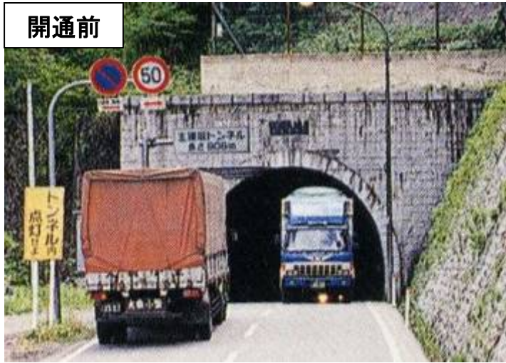
▲大型車のすれ違いが困難な主寝坂トンネル(H8.6)
