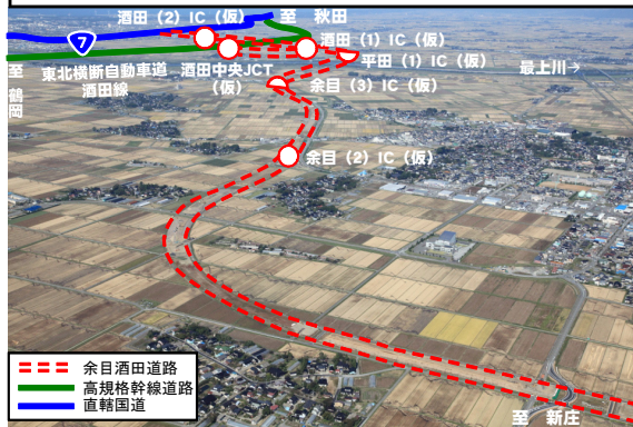
余目酒田道路整備状況 (L=12.7km) (起点側より終点側を望む)
