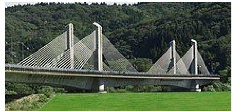
▲翔鷹大橋の特殊橋部分(エクストラロード橋)
