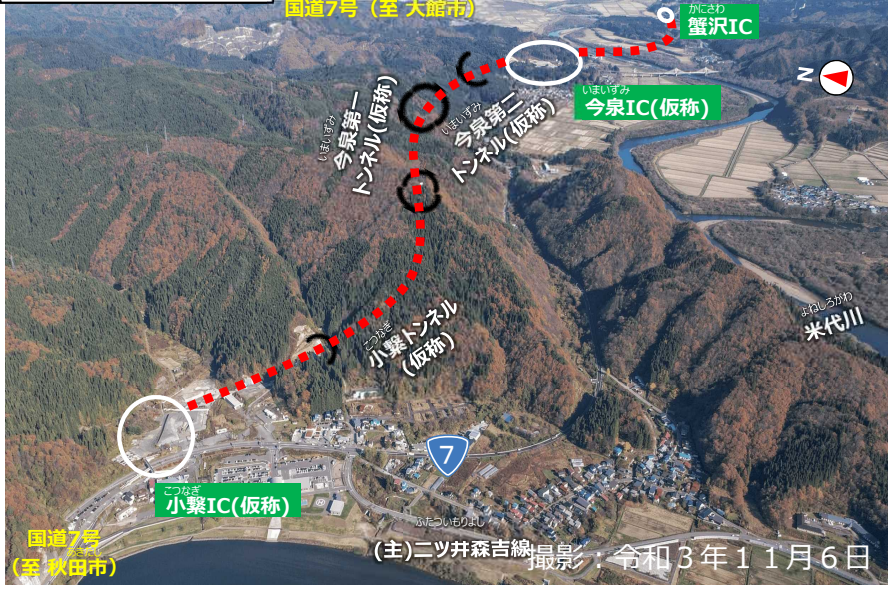
①起点側からの全景
