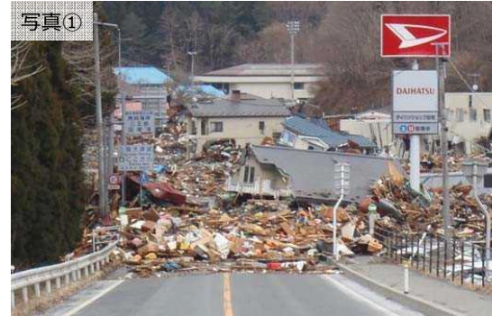
▼ 津波による被災状況 (宮古市田老地区) (H23.3)
