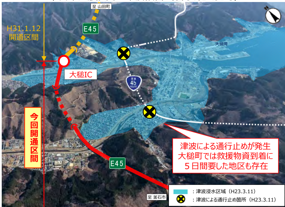
▼東日本大震災での津波被害（岩手県大槌町）
