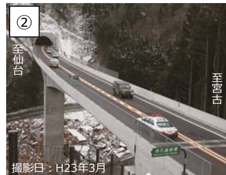
避難路・緊急輸送路として機能を発揮した 釜石両石IC～釜石北IC間
