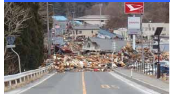
津波被災状況
