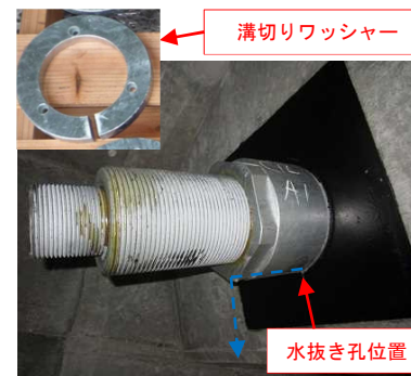
写真-9 定着鋼管内の水抜き
