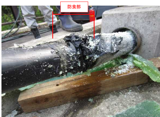
写真-5 引き抜き後防食部
