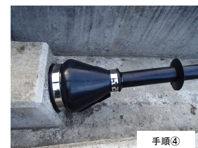
写真-7 鋼管小口部の止水対策
