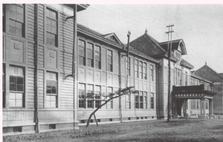
③完成した新校舎
