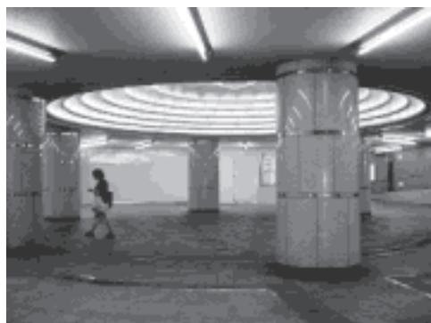
図7. 地下道での太陽光照明
