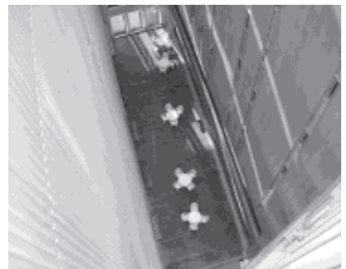
図 6. 研究室棟3階テラス
