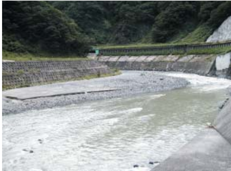
写真4 姫川本川スリット上流の右岸に形成した堆砂面 この下流の左岸には写真5～8の堆砂面を形成
