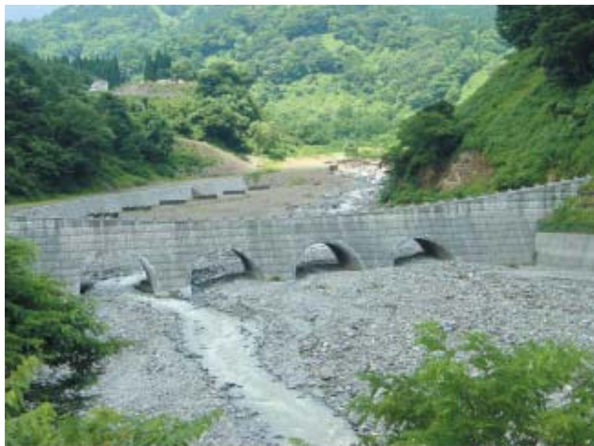
写真3 浦川スーパー暗渠砂防えん堤
