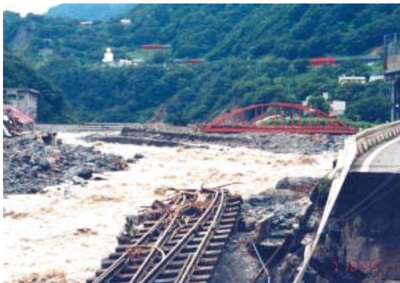
写真1 平成7年豪雨災害（平岩地区の被災状況）
