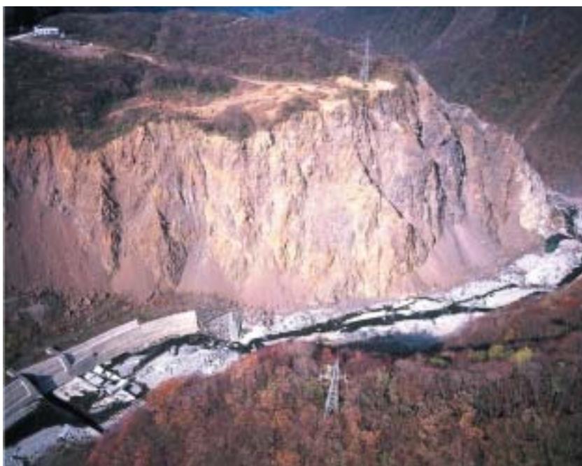
写真9 葛葉山腹工の施工箇所
