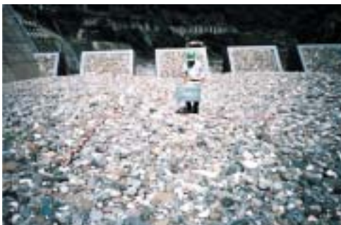
写真5～8 姫川本川スリット直上流に形成された堆砂面の変化 スリットの深さから年々と堆砂面が上昇していることがわかる
