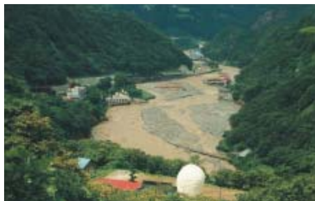
写真2 平成7年豪雨災害（出水前後の比較）
