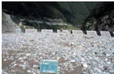
写真5～8 姫川本川スリット直上流に形成された堆砂面の変化 スリットの深さから年々と堆砂面が上昇していることがわかる
