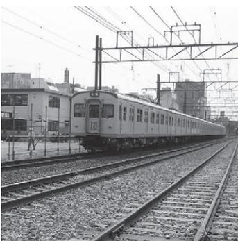
線路切り替えのため新しい線路(右)が敷設された大和駅地下化工事
