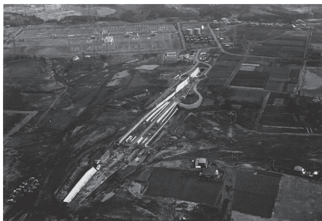
建設が進むいずみ野線(いずみ野駅)
