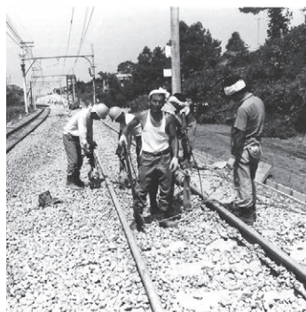
相模大塚～海老名間複線化工事
