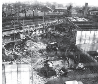
新相鉄ビル建設工事(Bブロック)
