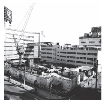
新相鉄ビル建設工事(Aブロック)
