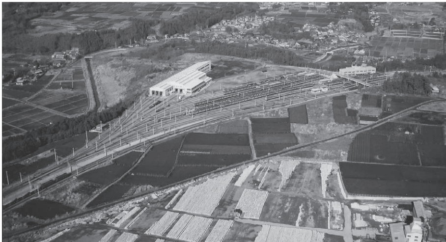
かしわ台電車基地全景
