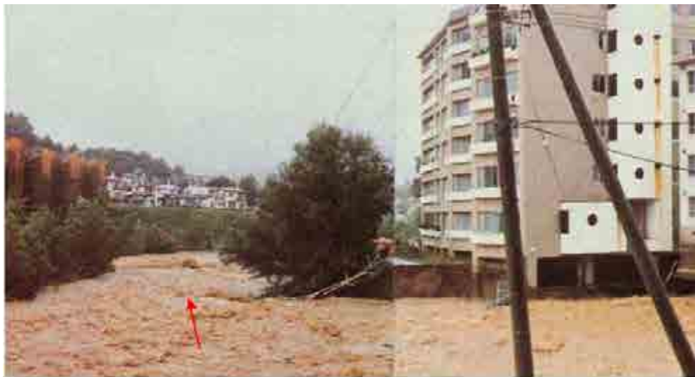
写真-27 昭和 56 年 8 月 23 日の水害（真駒内南町付近）
