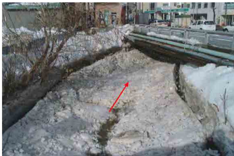
写真-26 平成14年1月21日の河道閉塞状況（国道12号上流）
