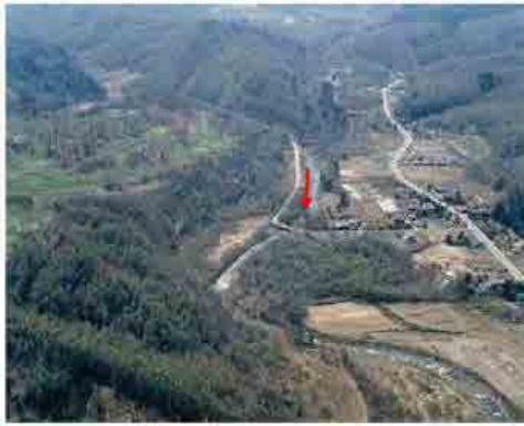
写真-33 上流域の河道状況 (真駒内ゴルフ場付近)
