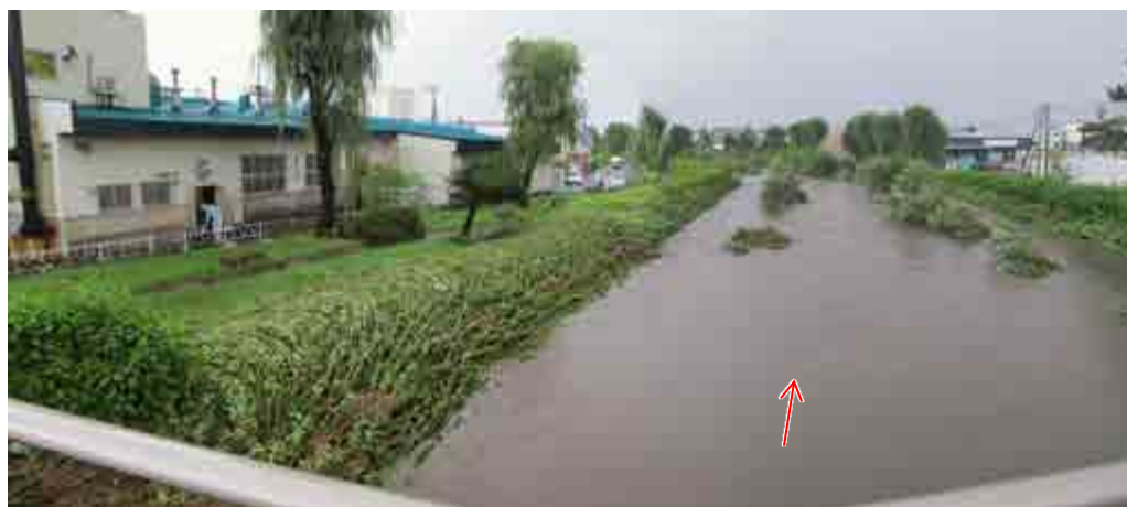
写真-24 平成 26 年 9 月の水害（本通橋付近）
