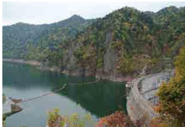
写真-2 豊平川上流域（豊平峡ダム）
