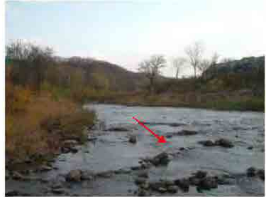
写真-34 中流域の河道状況 (真駒内1号橋付近)
