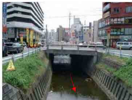
写真-32 中流域の河道状況 (地下鉄白石駅付近)
