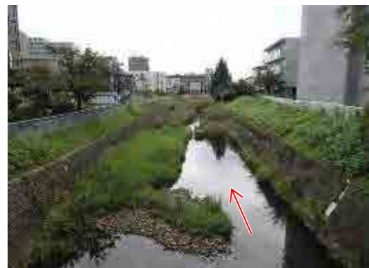
写真-30 中流域の河道状況 (東月寒橋下流付近)
