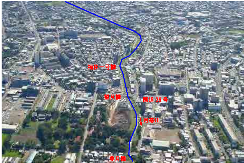
写真-13 国道36号付近
