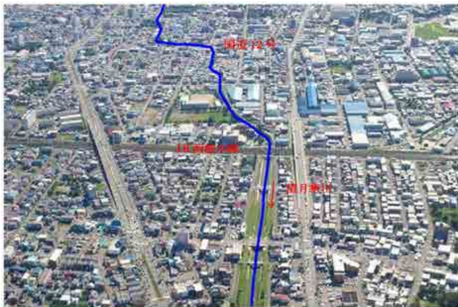
写真-19 JR函館本線周辺
