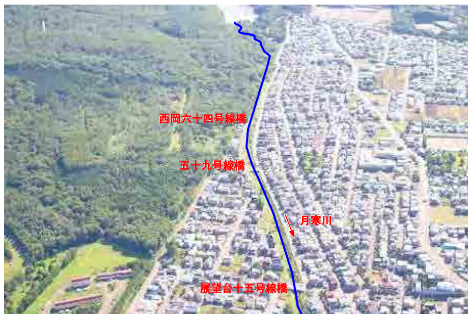
写真-12 西岡公園下流付近
