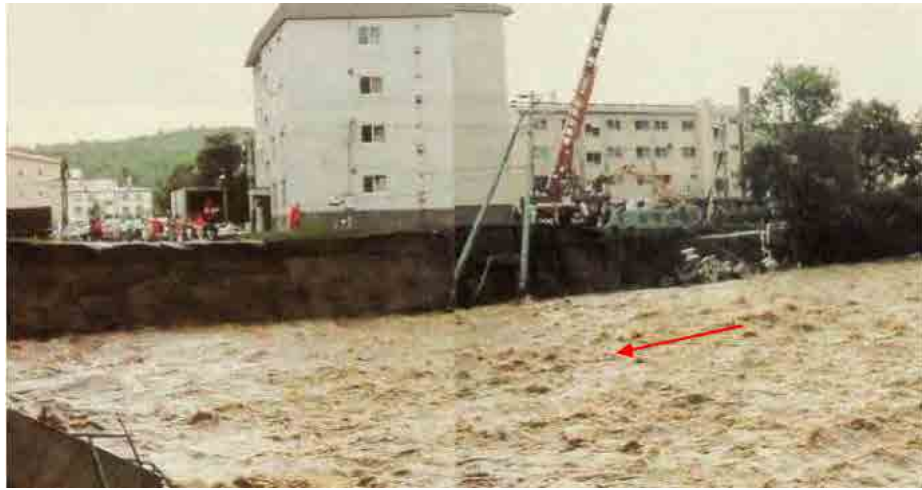
写真-28 昭和 56 年 8 月 23 日の水害（真駒内南町付近）
