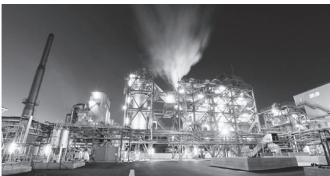
リサイクリングワーフ秋田の焼却溶融施設
