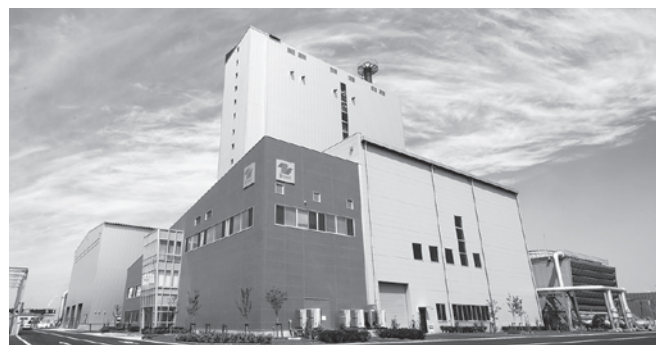
ユナイテッドリニューアブルエナジーのバイオマス発電所
