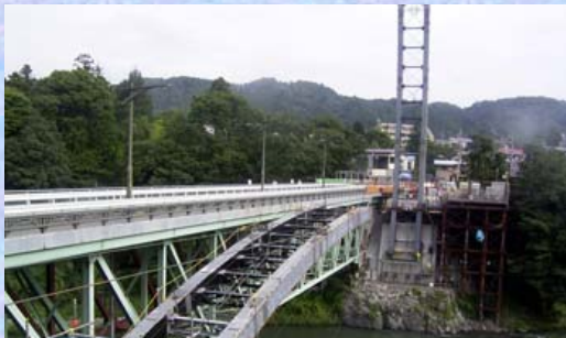
片側架設完了
