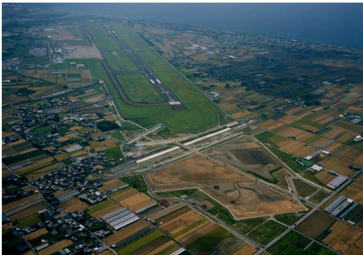
平成13年8月に撮影した高知空港拡張工事の全体状況写真
