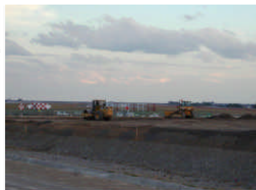
滑走路路床盛土状況
