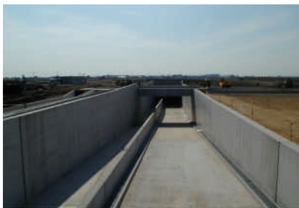
地下道の写真
