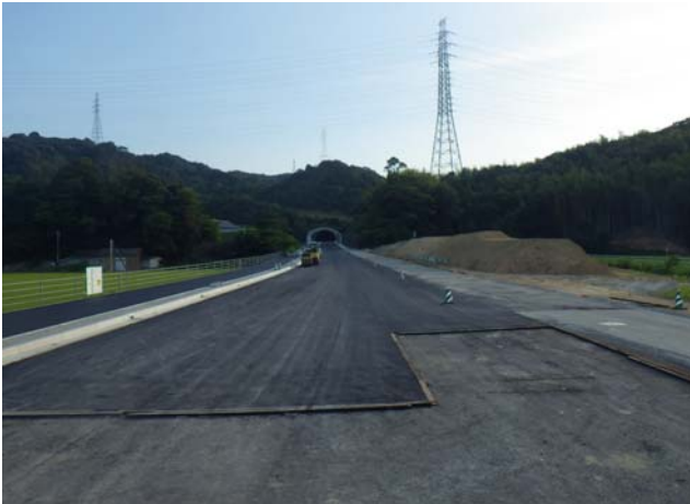
①舗装工事が進む西分地区 (H25. 7. 12撮影)
