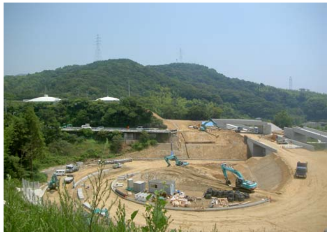
②改良工事が進む大浦地区 (H25. 7. 10撮影)
