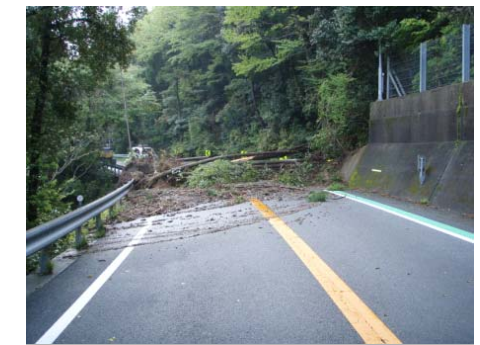
被災状況(H22.4)
