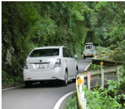
すれ違いが困難な現道の状況
