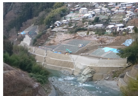
護岸工施工箇所
