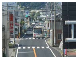
歩道が狭隘な国道55号 (阿南市津乃峰町東分付近)
