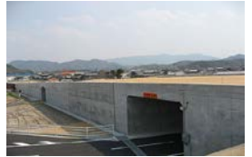
工事が進む大内白鳥バイパス (東かがわ市川東付近)
