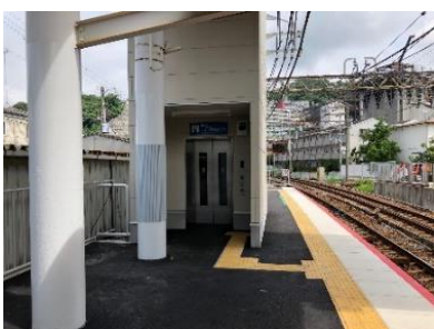
エレベーター（長田駅）
